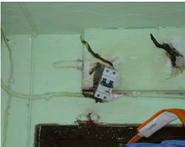
Detalle da instalación eléctrica
