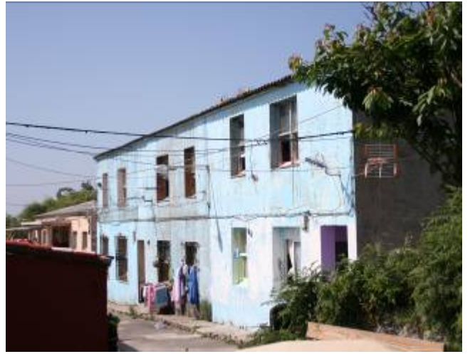
Fachada bloque tipo A
