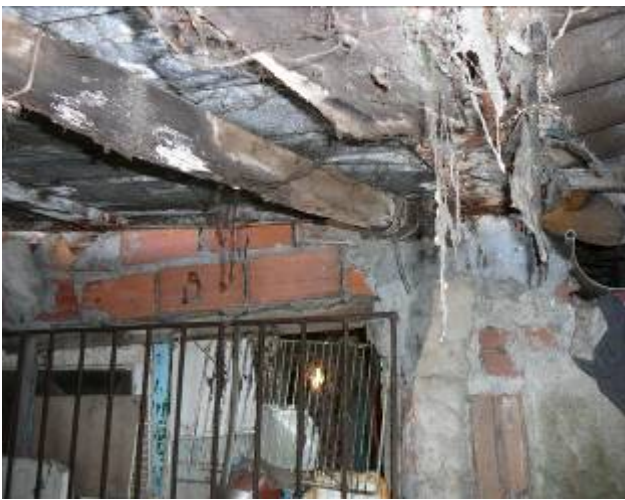
Vista interior de patio de vivenda en fileira
